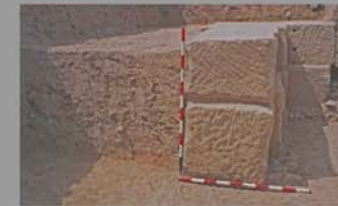
Detalle de una de las esquinas con sillaría de arenisca
